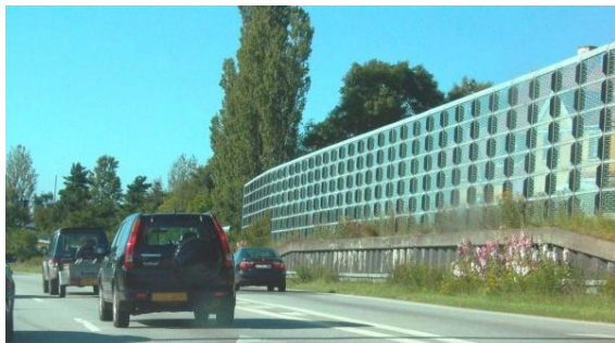
Partea frontală a unei bariere de zgomot de 5m amplasată pe un zid de sprijin de 1,5m în Copenhaga, Danemarca.
