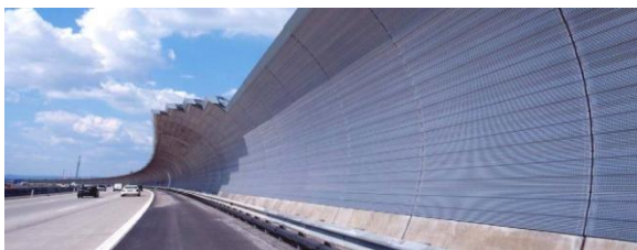
Barieră de zgomot în Viena, Austria, înclinată peste autostradă în vederea sporirii nivelului de reducere a zgomotului.
